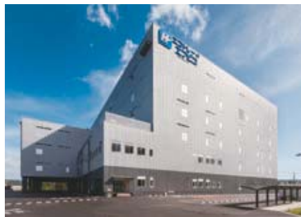
関西配送センター / アイ・ロジック関西ピッキングセンター(2013年10月稼働)
