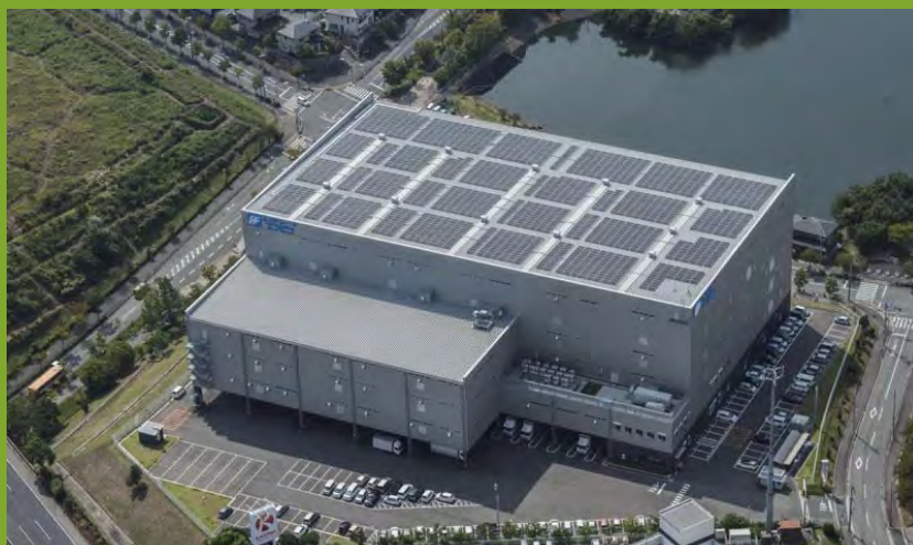
関西配送センターの屋上に設置した太陽光パネル。
