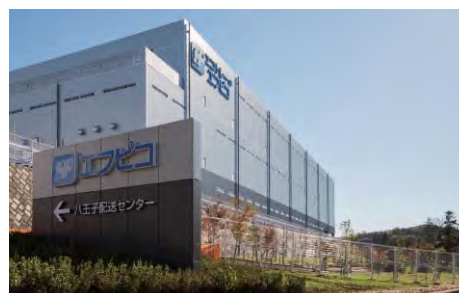
八王子配送センター
