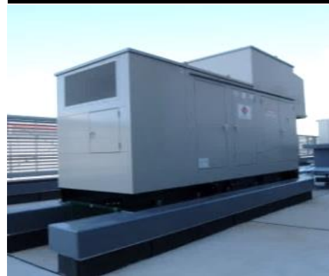
非常用発電設備
