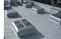
太陽光発電システム
