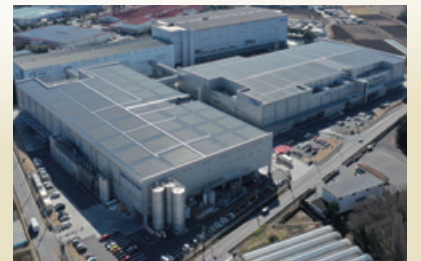
▲関東エリアの施設屋上に設置した太陽光パネル
