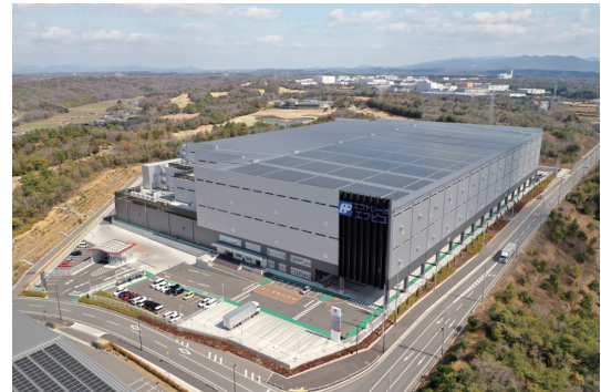
関西工場 太陽光発電設置
