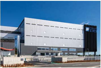
関西工場・関西ハブセンター
