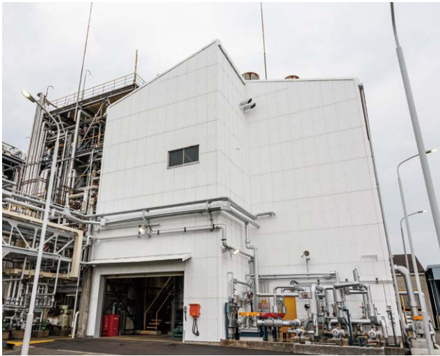
DIC 四日市工場に建設された、溶解分離リサイクル技術で色付きペレット（トレー素材）の脱墨を行うための施設
