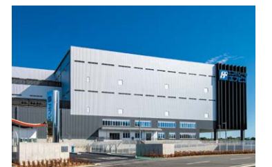
関西工場・関西ハブセンター
