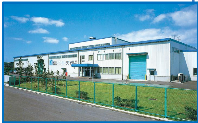
西日本ペットボトルリサイクル株式会社 所在地 福岡県北九州市若松区響町
