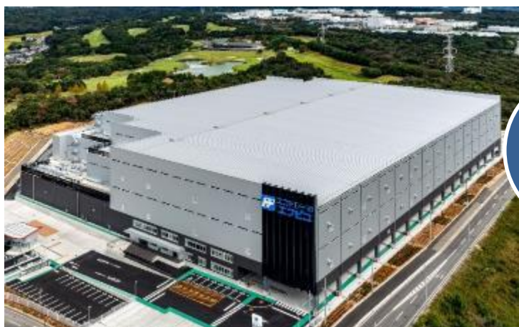
関西工場・関西ハブセンター
