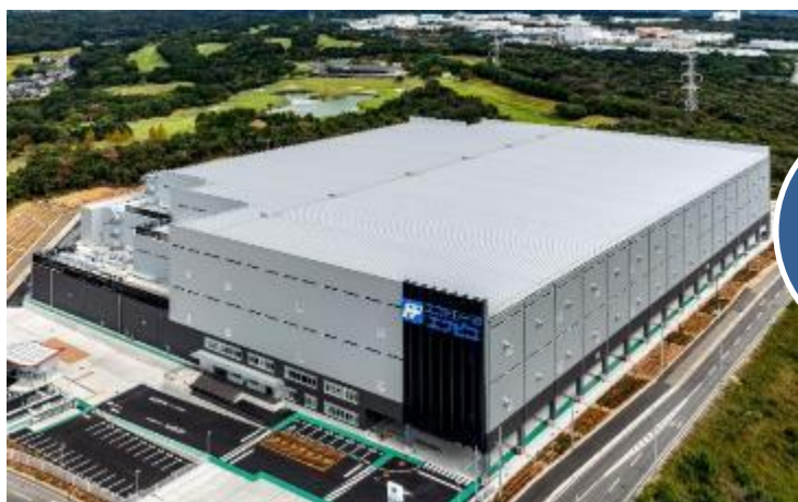
関西工場・関西ハブセンター
