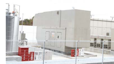
関西ハブセンターに配備した72時間稼働可能な非常用電源設備
